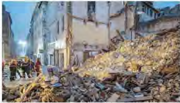
Les secours marseillais ont toujours à la recherche de victimes dans les débris des immeubles écroulés du quartier Noailles.
